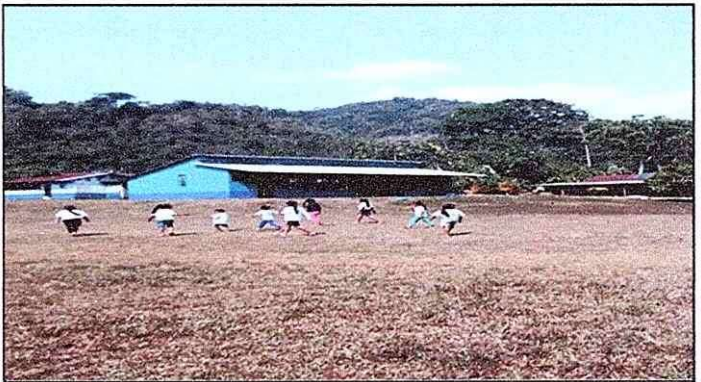
Foto 4: Mantemiento por falta de muro perimetral
